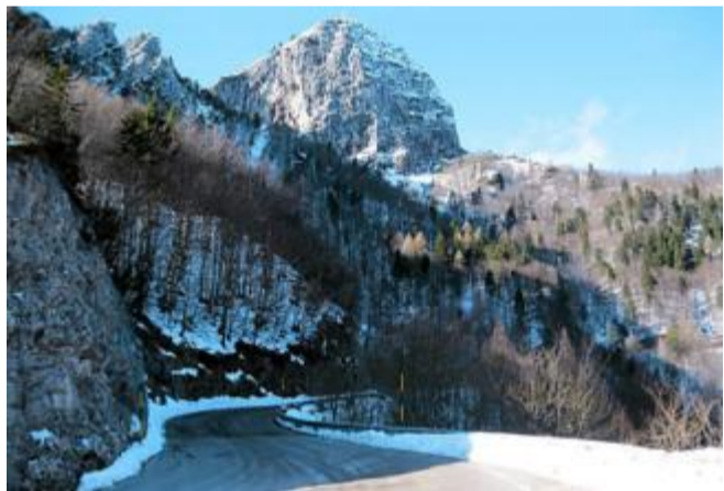
Uno dei tratti sotto lo Spitz liberati dal materiale crollato. G.M.F.
